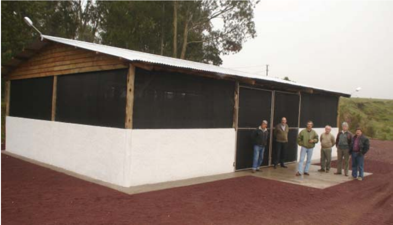
Centro de acopio en Lascano
